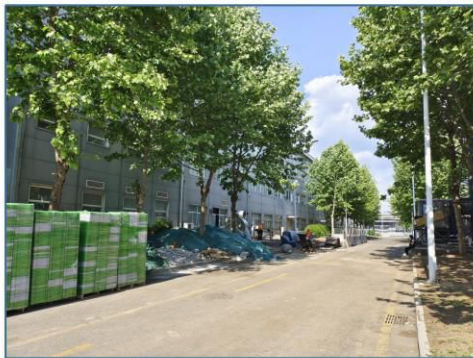
A 区 D2 厂房外部环境
