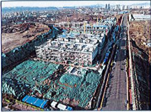
光机电产业园（一期）建设现状
