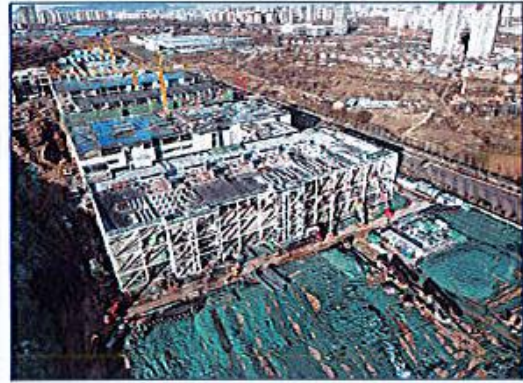
光机电产业园（一期）建设现状
